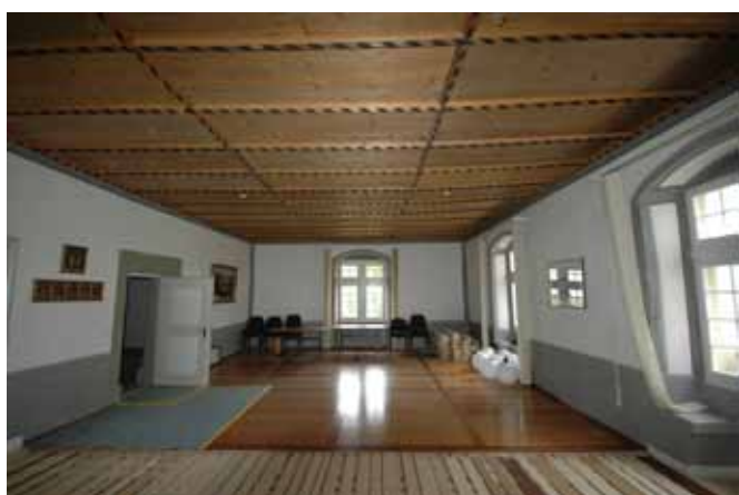
Der Wappensaal während der Sanierung
