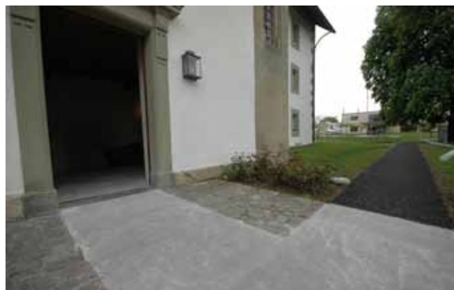
Der neue direkte, behindertengängige Zugang vom und zum Parkplatz und zum Pflegezentrum
